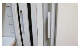
Marco reforzado con alojamiento para placa longitudinal en 1993, E-1993 y E-19130
